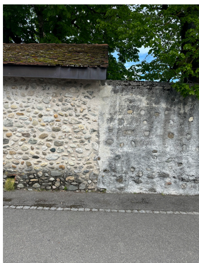
Murs en boulets alluvionnaires
