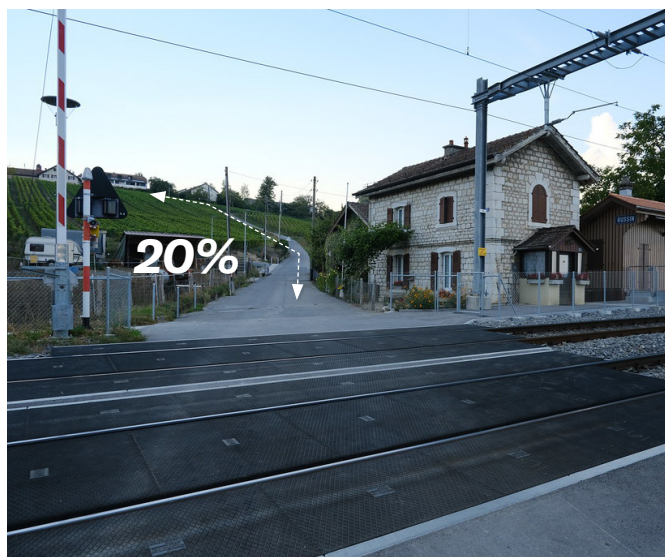
Liaison gare-Village et pente impraticable par verglas et pour les PMR
