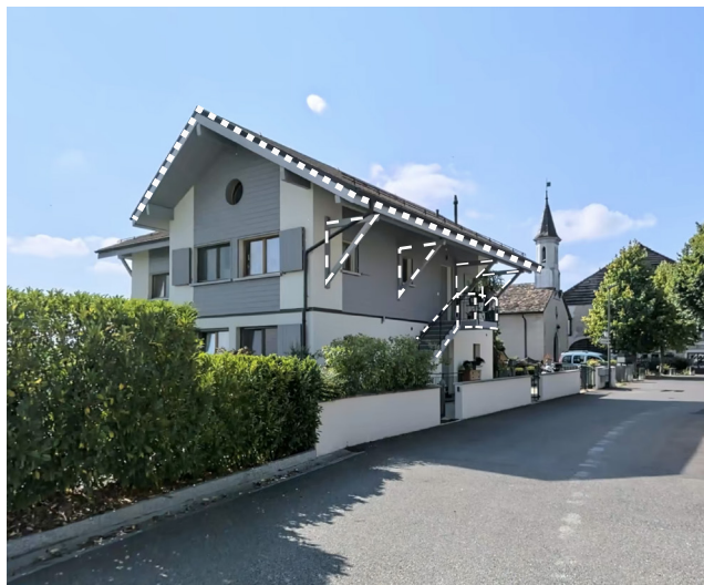
Toits en bâtière prolongés d'avant-toits proéminents grâce à des corbeaux
