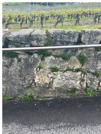
Mur en pierres
