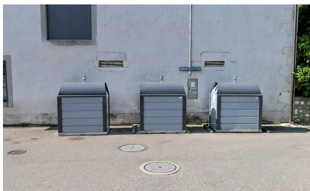
Espace poubelles, ch. de la Croix-de-Plomb
