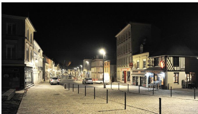
Traitement de sol de façade à façade, Orbec
