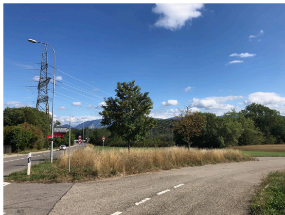
Croisement rte de Verbois / rte de l'usine de Verbois
