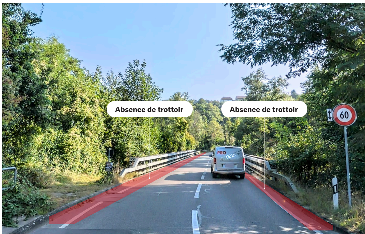
Route du Mandement à hauteur du pont routier sur l'Allondon
