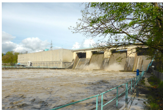
Barrage hydroélectrique de Verbois
